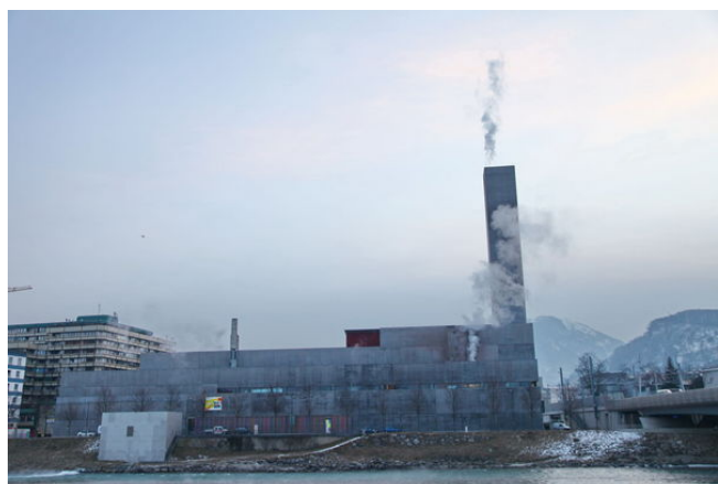
Abbildung 15: Ausfalls des HKW Mitte am 04.02.2012 [6]
